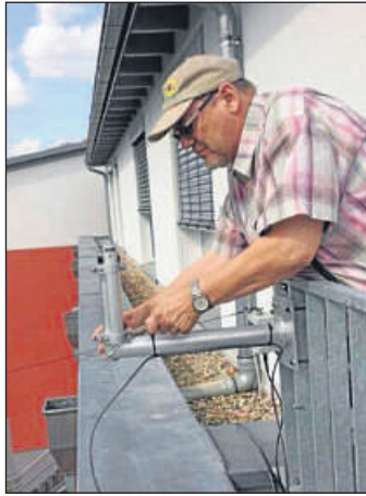
Montage der Antennen: Wolfhard Eidenmüller installierte mit drei Mitgliedern des Deutschen Amateur-Radio-Club Ortsverband Vellmar eine UKW- sowie eine Kurzwellenantenne.
